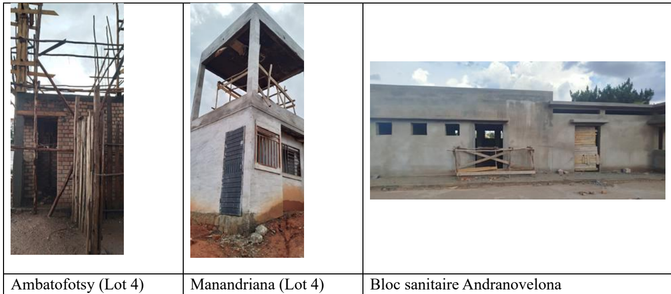
Photo 2. Forages et BSAN non encore réalisés
