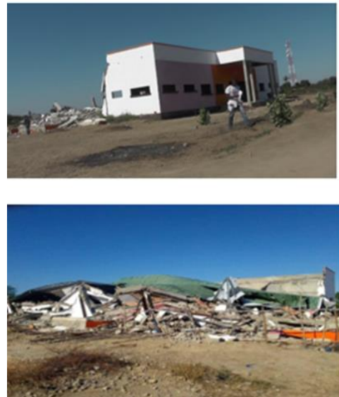
Figure 6: MCC de Morondava après effondrement
