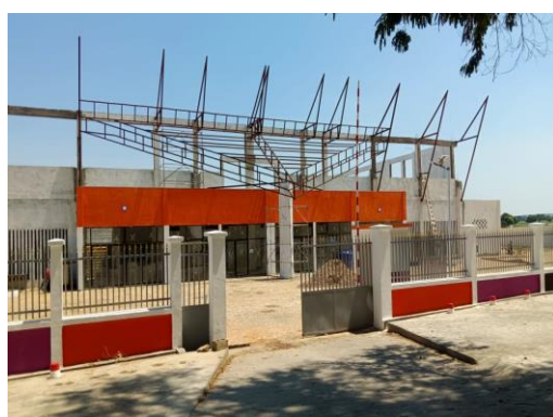
GYMNASE DE 1000 PLACES SAKARAH (Construction et aménagement extérieur)
