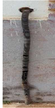
Photo 13 : Usure de gaines de protection des câbles au CSB2 Ambohimasina
