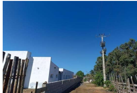
Photo 10: CHM Farafangana en cours de construction
