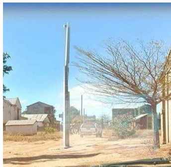
Photo 7: Poteaux levés sans câbles dans la localité de Miarinarivo
