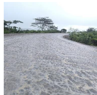
Figure 1: Produit imprégné partiellement lessivé
