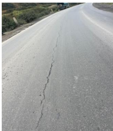
Figure 3: Fissure longitudinale
