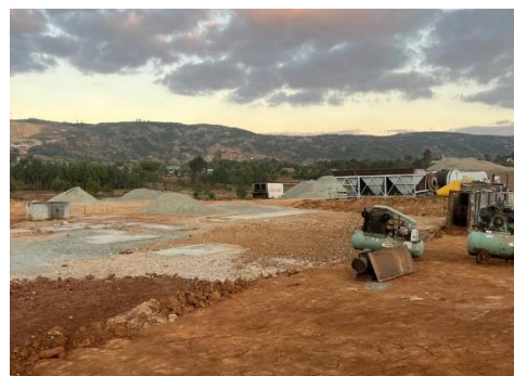
Figure 2: Zone d'installation de la centrale d'enrobage au Pk 138
