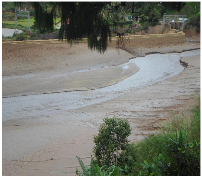
Le lit du canal menant aux installations de la centrale hydroélectrique d'Antelomita 2 envahi par le sable
